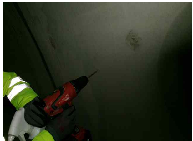
탄산화깊이 측정 현황
