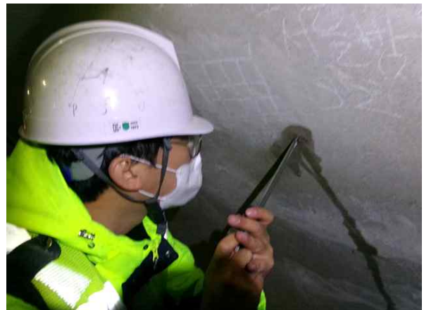
탄산화깊이 측정 현황
