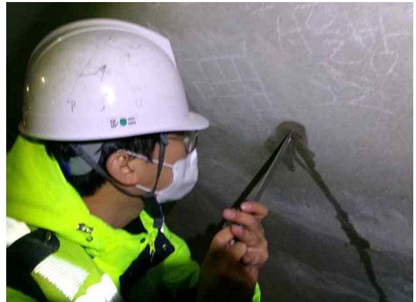
탄산화깊이 측정 현황
